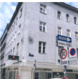
DG-Ausbau, Sanierung Altbestand und Allgemeinflächen, Abverkauf
