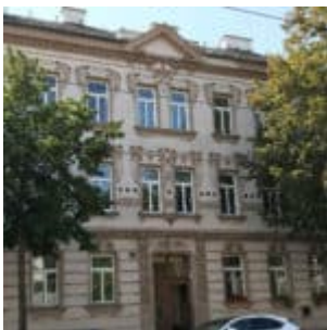
DG-Ausbau, Sanierung Altbestand und Allgemeinflächen, Abverkauf
