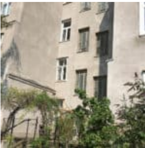
DG-Ausbau, Sanierung Altbestand und Allgemeinflächen, Abverkauf
