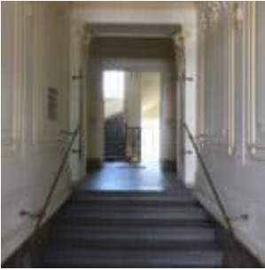
DG-Ausbau, Sanierung Altbestand und Allgemeinflächen, Abverkauf
