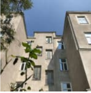
DG-Ausbau, Sanierung Altbestand und Allgemeinflächen, Abverkauf
