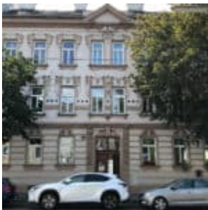
DG-Ausbau, Sanierung Altbestand und Allgemeinflächen, Abverkauf
