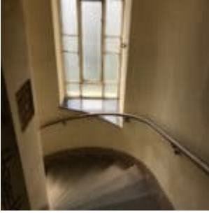
DG-Ausbau, Sanierung Altbestand und Allgemeinflächen, Abverkauf
