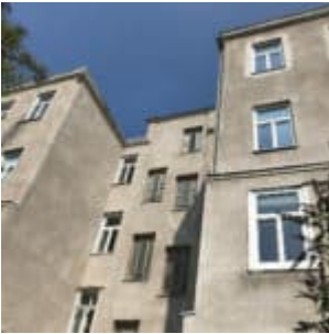
DG-Ausbau, Sanierung Altbestand und Allgemeinflächen, Abverkauf
