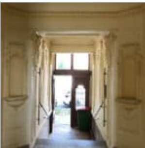
DG-Ausbau, Sanierung Altbestand und Allgemeinflächen, Abverkauf
