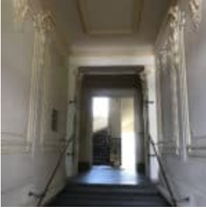
DG-Ausbau, Sanierung Altbestand und Allgemeinflächen, Abverkauf
